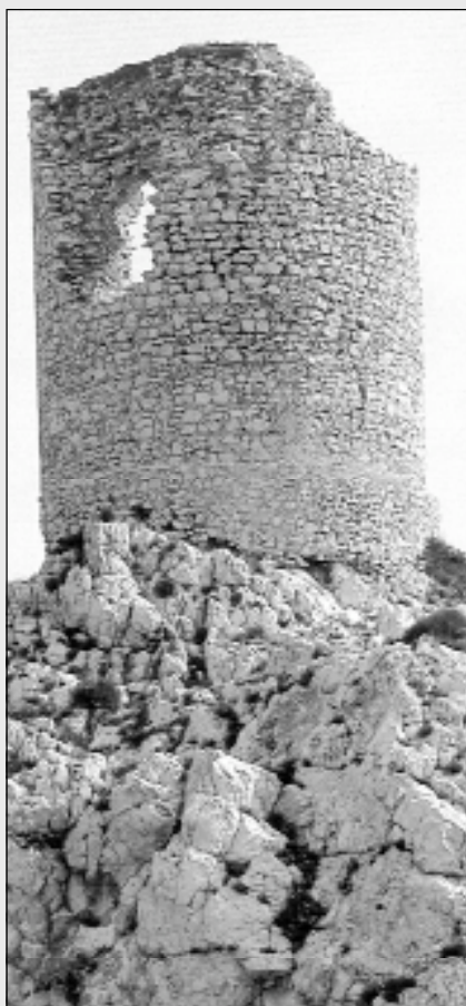
Torre di Terrasini
